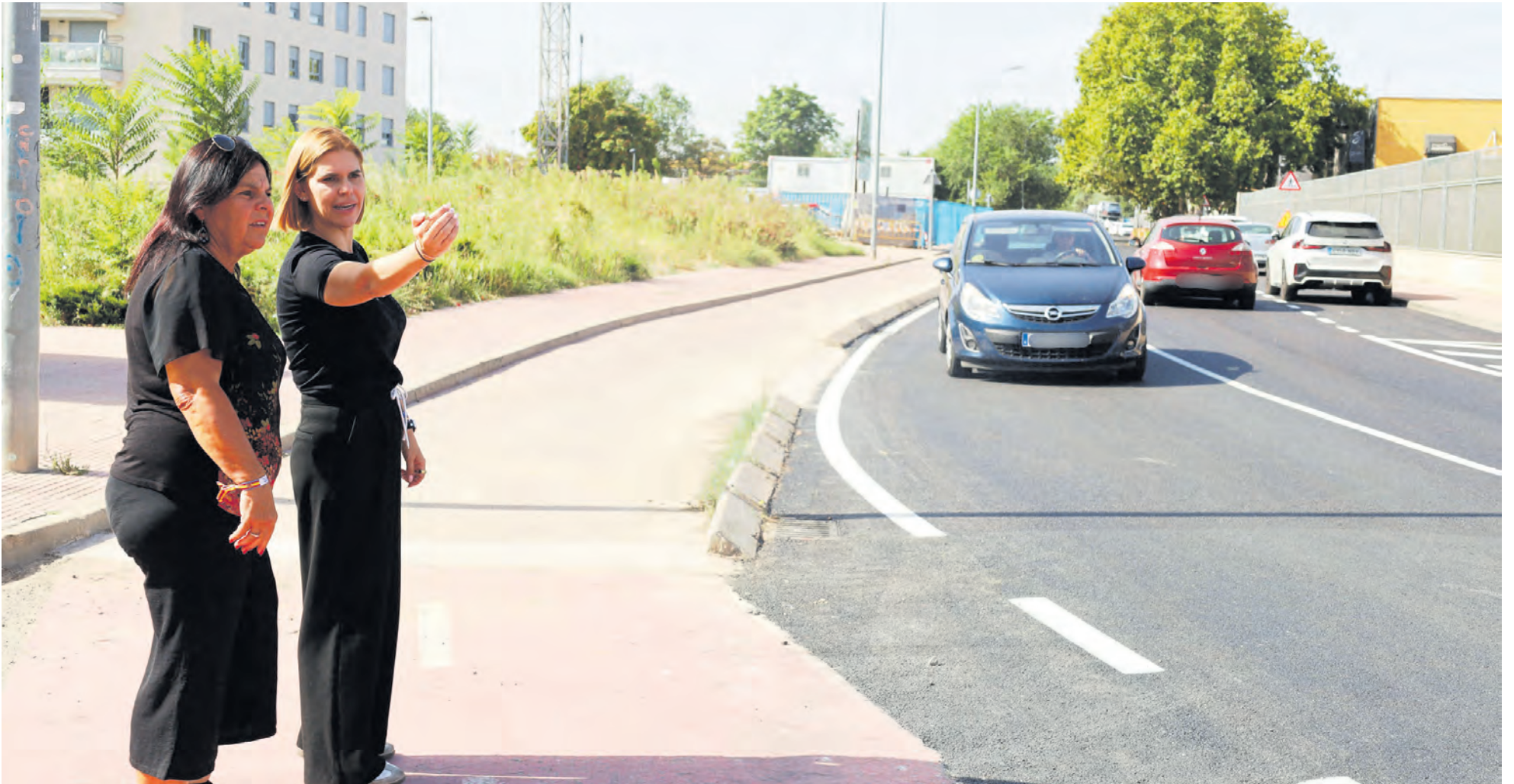
Para completar la actuación, se instalaría un nuevo resalto en la calzada para mejorar la seguridad vial a petición de los vecinos de la calle Varia.
