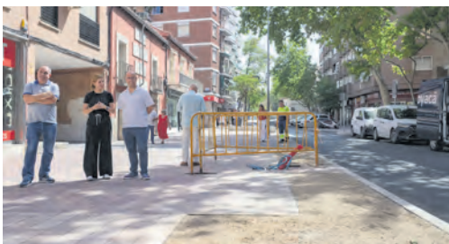
La calle Teniente Ruiz gana espacio para los peatones con la ampliación de las aceras tras una inversión de 500.000 euros
